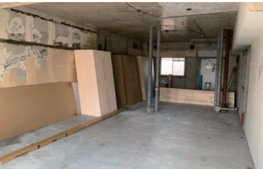
解体後スケルトン
