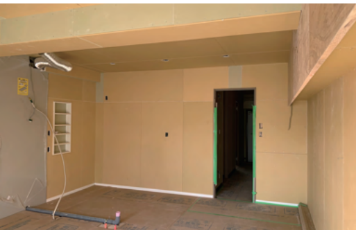
間仕切り・PB 貼り・木枠取付
